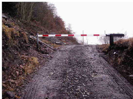
Afsluiting TGV Vaux-sous-Chrevemont
